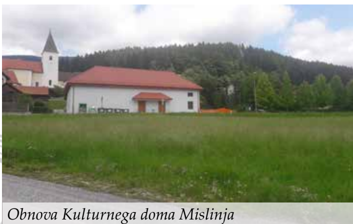
Obnova Kulturnega doma Mislinja
